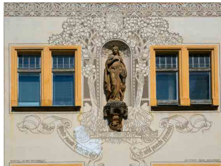
Bogata dekoracja sgraffito i pomnik Elzbiety Pomorskiej na fasadzie kamienicy Wiktora Weinhengsta, ukończonej w 1899 roku (Eliščino nábřeží 310).
