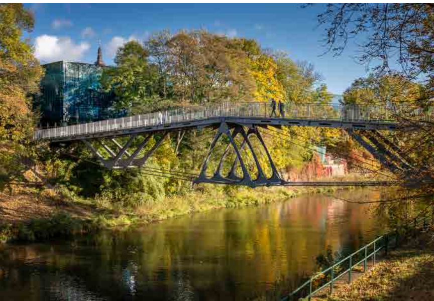
Lávka přes Orlici, v pozadí zimní stadion ČPP aréna.
