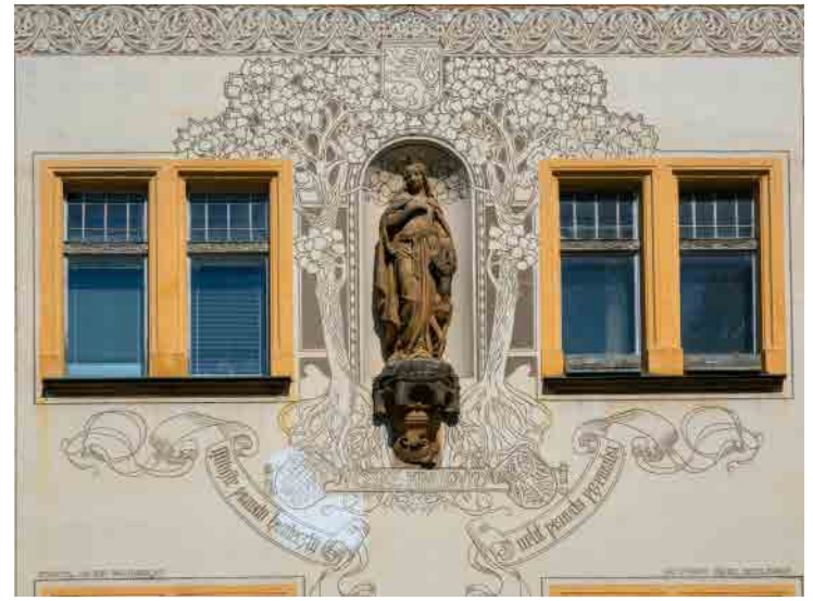
Bohatá sgrafitová výzdoba a socha Elišky Pomořanské na průčelí čínžovního domu Viktora Weinhengsta , dokončeného roku 1899 (Eliščino nábreží 310).
